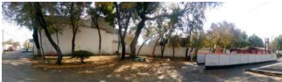
Imagen 96. Exteriores de la estación del Metro Vallejo, salida sur
