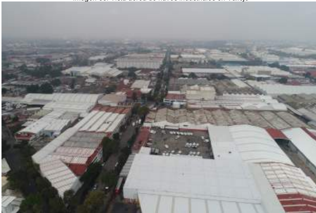
Imagen 33. Vista aérea de naves industriales en Vallejo
