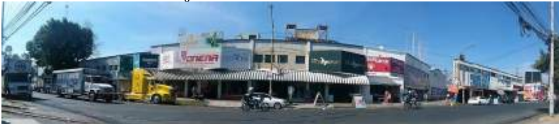
Imagen 50. Zona comercial de calle Norte 45
