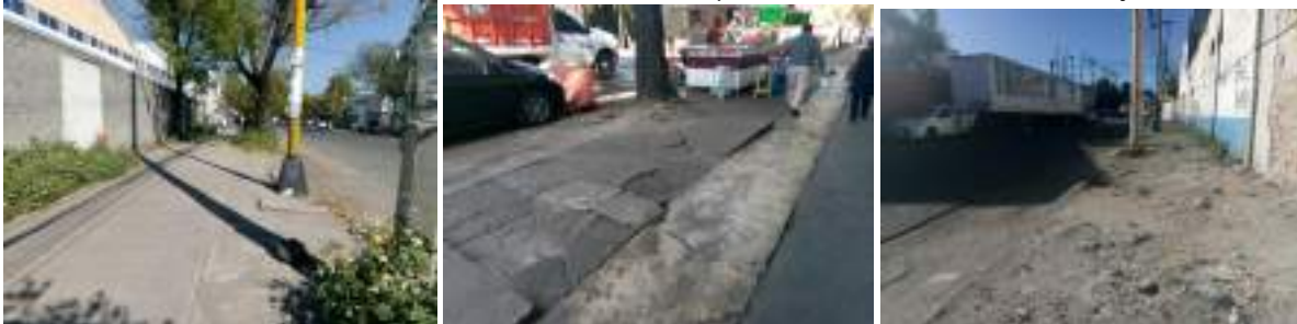
Imagen 83. Estado de conservación de las banquetas en la zona del PPPDU Vallejo
