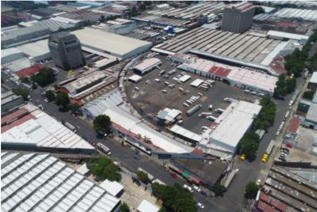
Imagen 39. Asentamientos irregulares sobre las vías del tren
