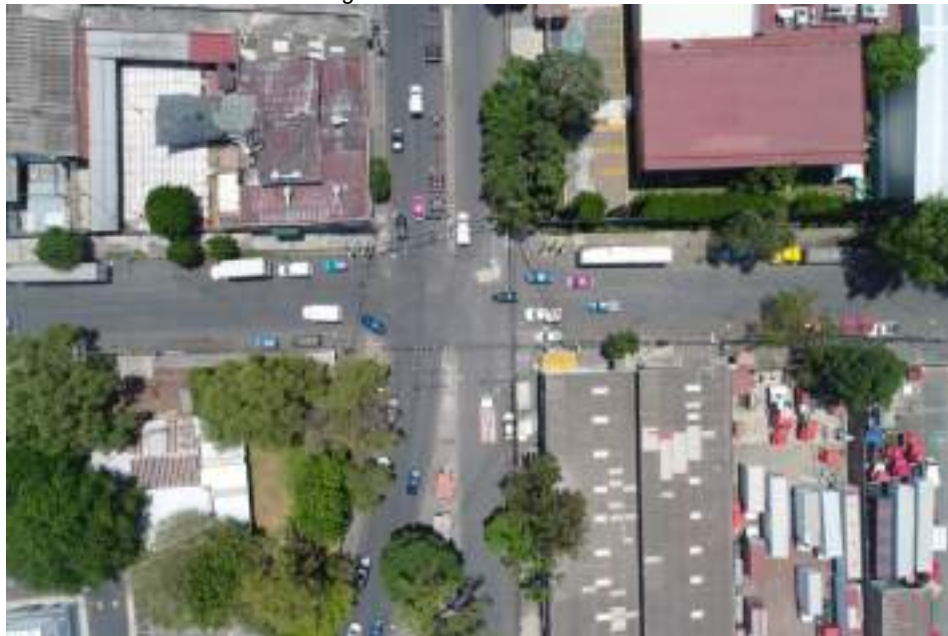
Imagen 142. Vista aérea de cruce
